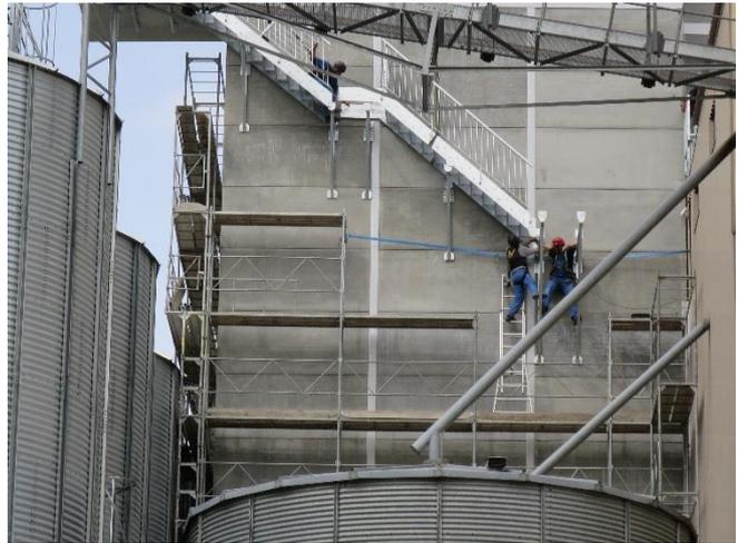
Die Fluchttreppen werden montiert.
