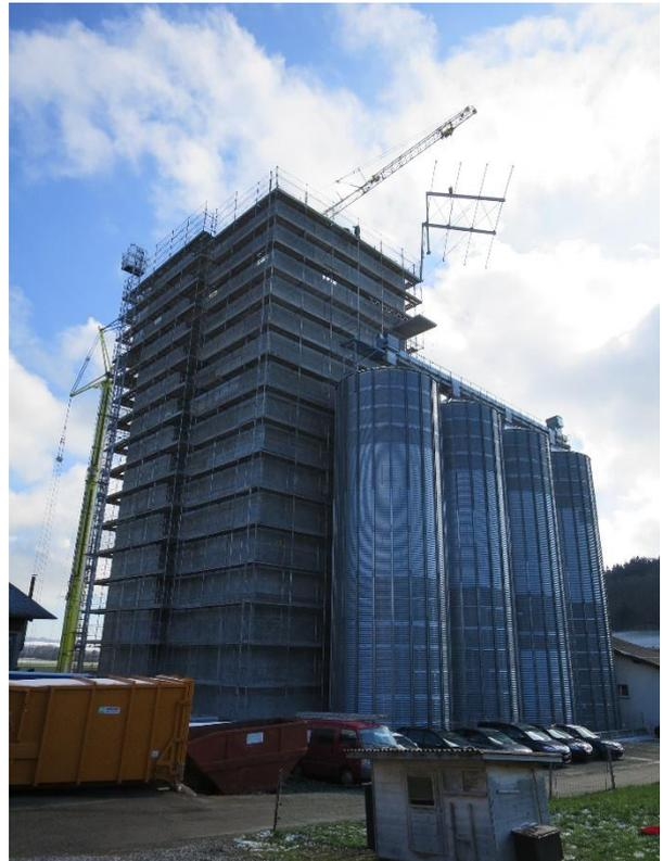
Die Dachkonstruktion wird mit Hilfe eines Autokrans aufgesetzt.
